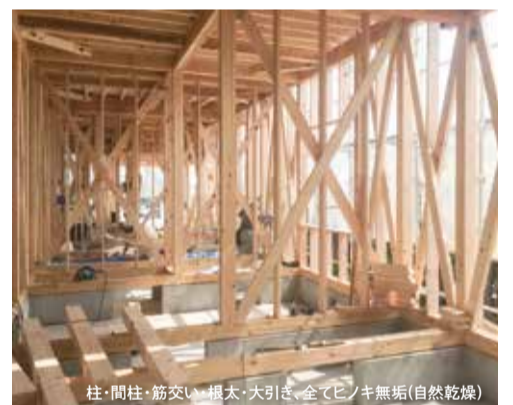
柱・間柱・筋交い・根太・大引き・全てヒノキ無垢(自然乾燥)
